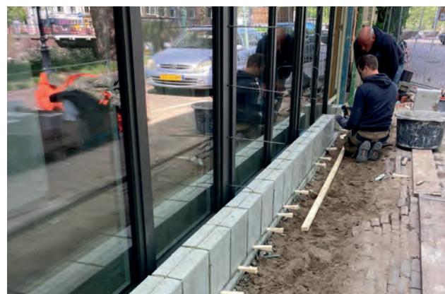
Mei 2022: de muur van betonelementen wordt met grote precisie gemetseld.
